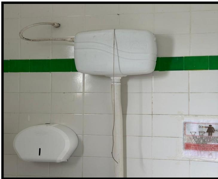
Figura 12 – Corda de acionamento da descarga arrebetada
